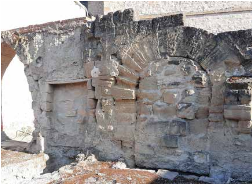
Arco visigodo por la cara norte. El vano adintelado corresponde al arco visigodo contiguo. Entre ambos está la base del muro de separación entre las supuestas Sala Capitular y la cocina de la Limosna (Axonometrica D y E) (Foto ANM, 2021)
