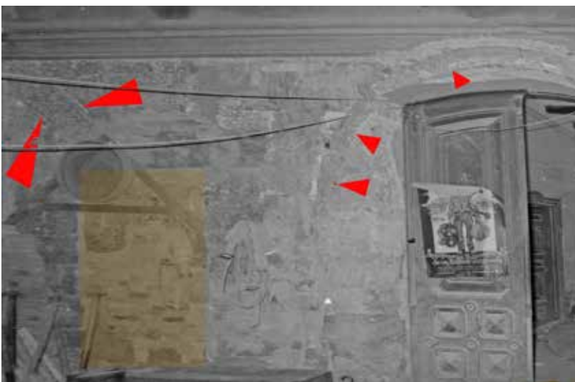
Muro con arco de medio punto antes de ser enlucida la pared. Fotos en blanco y negro, yuxtapuestas, tomadas con distinta angulación (Foto ANM, 1978)
