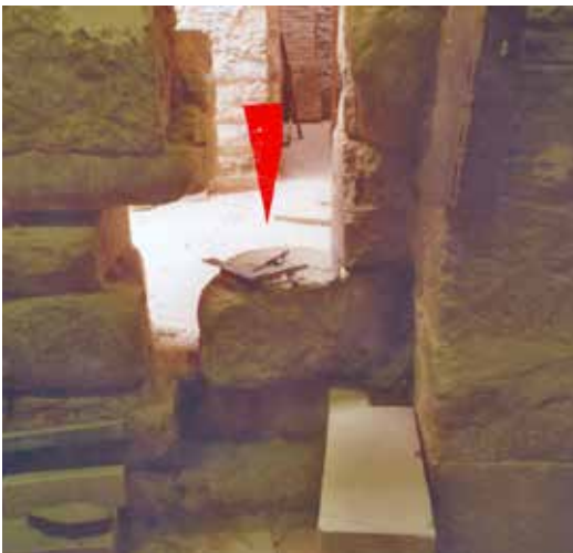
Basa-testigo de la existencia de arcos, similar a las de los arcos contiguos del frente o crujía norte Axonométrica, A7),(Foto C. Goñi)
