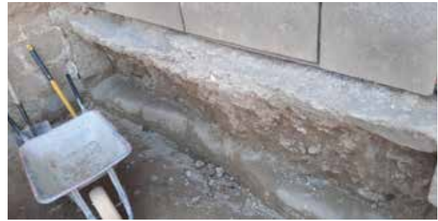
El nivel actual del claustro está recrecido sobre escalón con desgaste (Axonometrica D),(Foto ANM, 2020)
