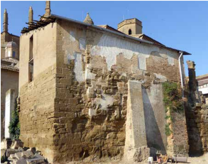
Canónica, edificio de los machones (Enfermería): aparejo de épocas diferenciadas (Foto ANM, 2018) (VER foto p. 32)
