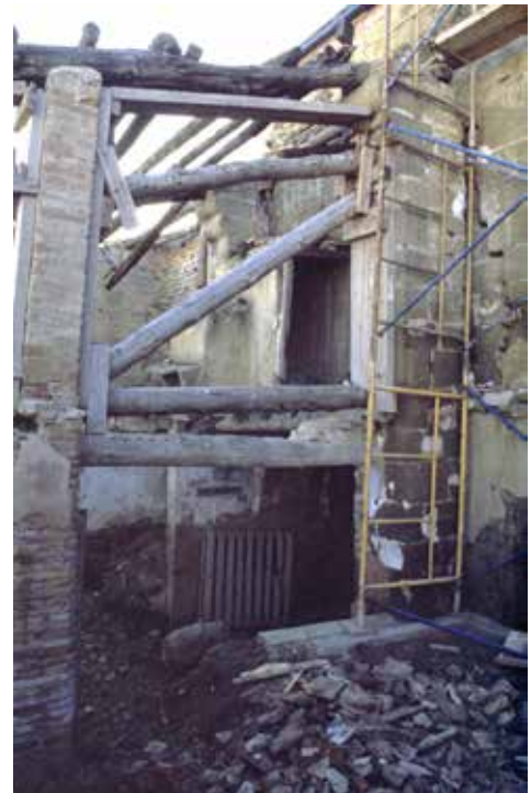
El piso superior es consecuencia de la existencia de arcos. El inferior fue montado cuando estos se perdieron (Foto C. Goñi)
