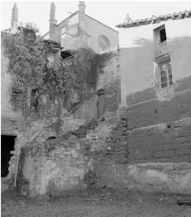
Rampa desaparecida en 1979 (Foto ANM, 1978)
