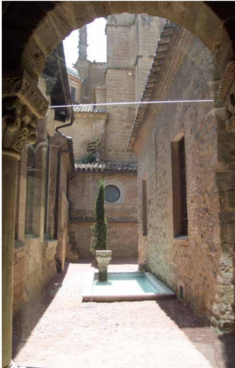
Patio interior del claustro románico (Foto ANM, 2004)
