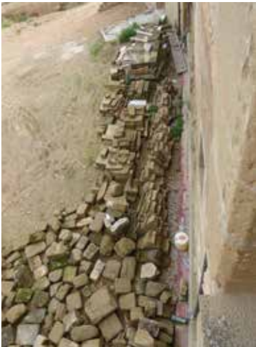
Acumulación de restos de trabajos históricos con las dovelas de la Limosna ((Foto ANM, 2018)
