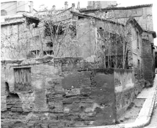
Calle de Forment. Ubicación de ventanas para echar la uva a los lagares (Foto MALM,1974)
