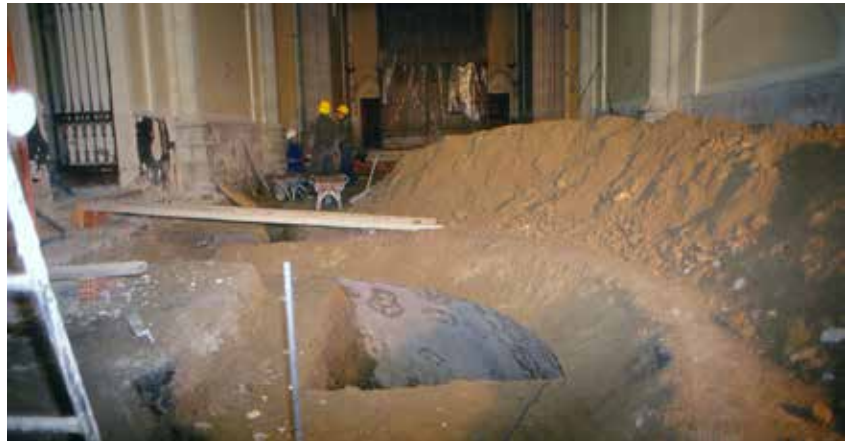
Excavación en el aljibe, año 2000 (Foto ANM)
