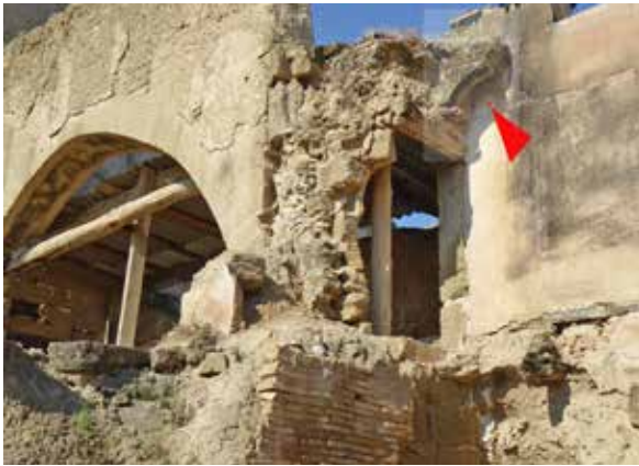
Canete de tejado medieval en el muro donde estaba el doble arquillo medieval (Foto ANM, 2018)
