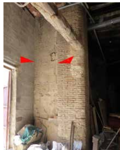
Fragmento de la fachada norte de la casa, en la esquina de la calle de la Limosna (Foto ANM 2018)
