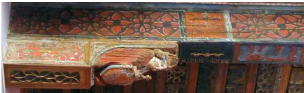
Reposición de letras inadecuadamente colocadas (Foto ANM, 2017)
