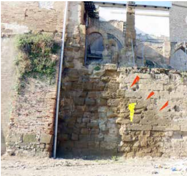
Aparejos diferenciados en la plataforma-zócalo y alzados. Izquierda, junto a la bajante, restos del muro que ocultaba la puerta en arco (Foto ANM, 2018)
