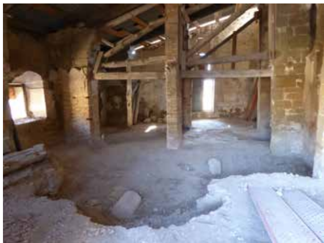
Interior actual del edificio de los machones, "casa del Perrero-Macero" o Enfermería (Axonométrica C), (Foto ANM, 2019)
