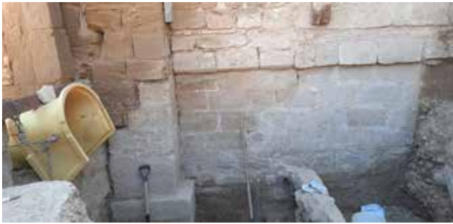
Intervención de refuerzo y muro de separación embebido, no trabado (Axonometrica D1),(Foto ANM, 2020)
