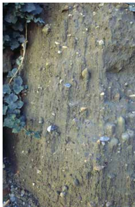
Fragmento del tapial del muro norte (Foto C. Goñi)
