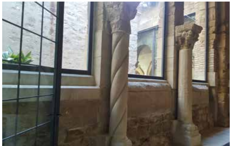
Capiteles originales sobre columnas de Escuela Taller. Sarcófagos sobre muro reaprovechado y reforzado (Foto ANM)
