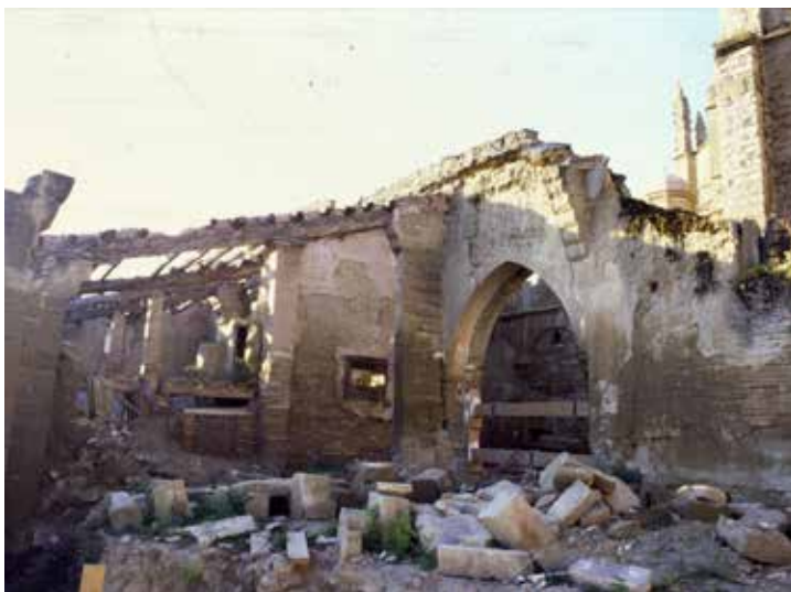
Arco que tuvo la puerta adintelada y ventana enrejada encima, para acceso al pasillo (Foto ANM, 1996)
