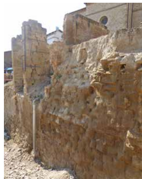
Muro norte de la Sala de la Limosna, soporte del tapial (Foto ANM, 2018)
