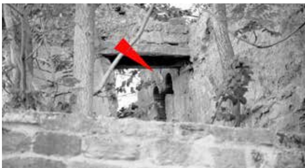
Doble arco desaparecido, que data el muro medieval (Foto ANM, 1987)
