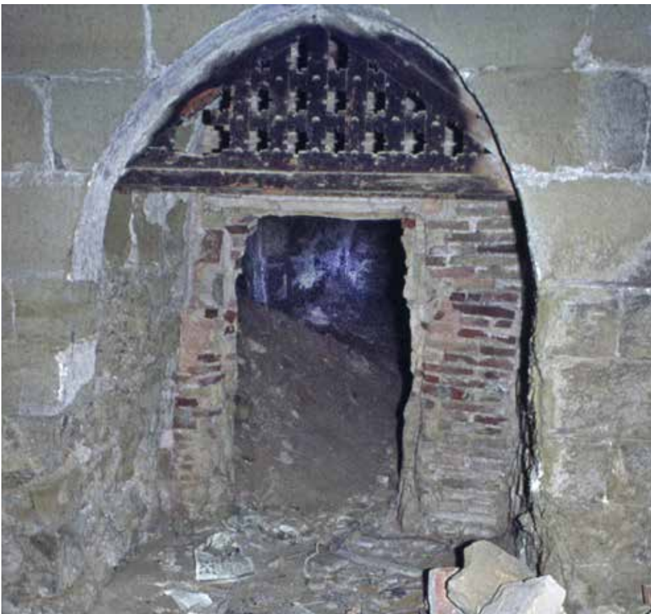
Conexión entre los dos celleros, actualmente transformada (Foto C. Goñi)
