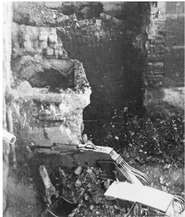
Rampa desaparecida (Foto Tricas, 1979)
